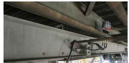
Schmierung des Lüfters (Fin Fan) einer Wärmetauschanlage
